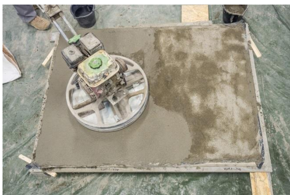
Obrázek 7: Hlazení povrchu hladičkou o průměru 60 cm
