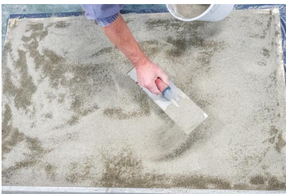
Obrázek 6: Aplikace vsypu
