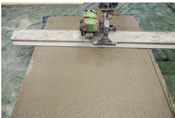
Obrázek 5: Hutnění vibrační latí
