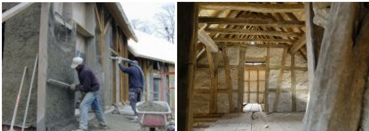
Obr. 5.2 : Ukázky úpravy povrchu vnitřní stěny [10]
