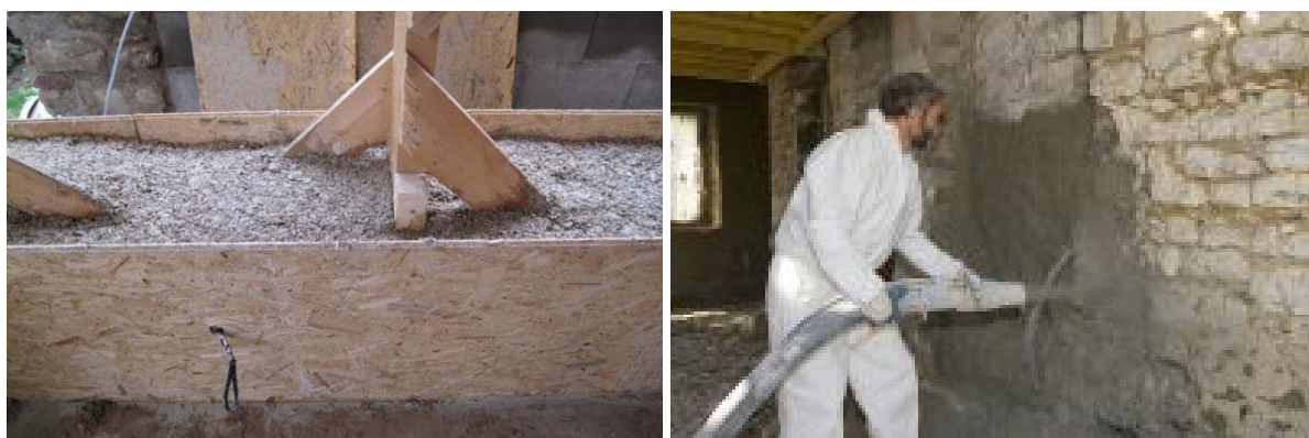
Obr. 5.1 : Ukázky aplikací cemento konopných kompozitů – ukládání do bednění (vlevo), aplikace stříkáním (vpravo) [10]
