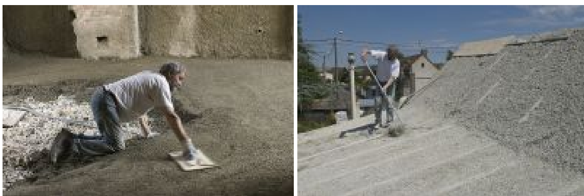
Obr. 5.3 : Ukázky výplně podlahové a střešní konstrukce [10]
